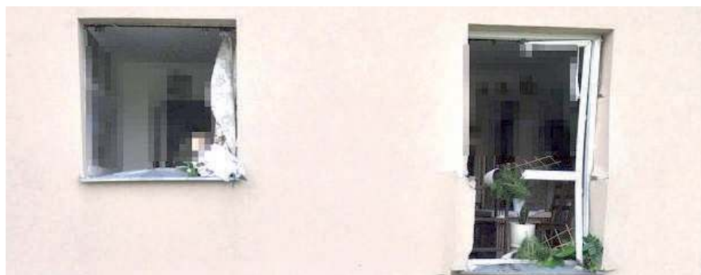
Eksplozja była na tyle silna, że okna wyleciały na zewnątrz
