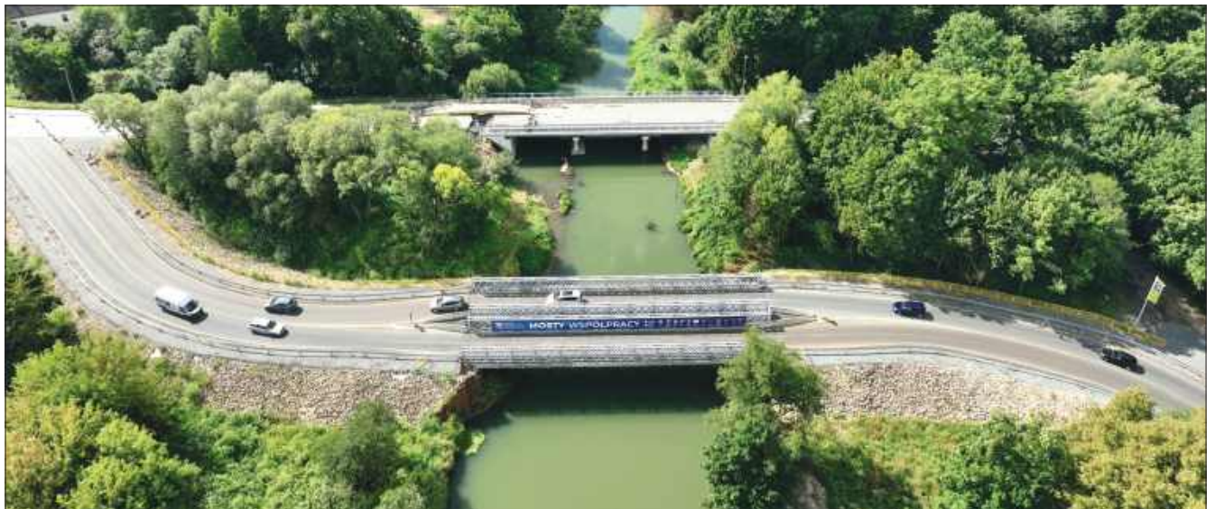
■ Projekt zakłada budowę mostu na Odrze o długości 600 m i szerokości 14 m wraz z dojazdami i dwoma rondami (z DK45 i DW416 oraz DW423)
