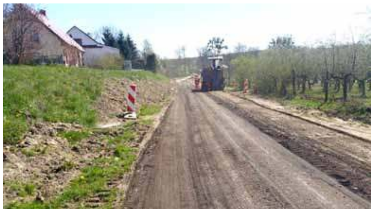
Trwa budowa drogi na odcinku Słodkowo-Suchań. Pracownicy rozpoczęli profilowanie pobocza drogi
