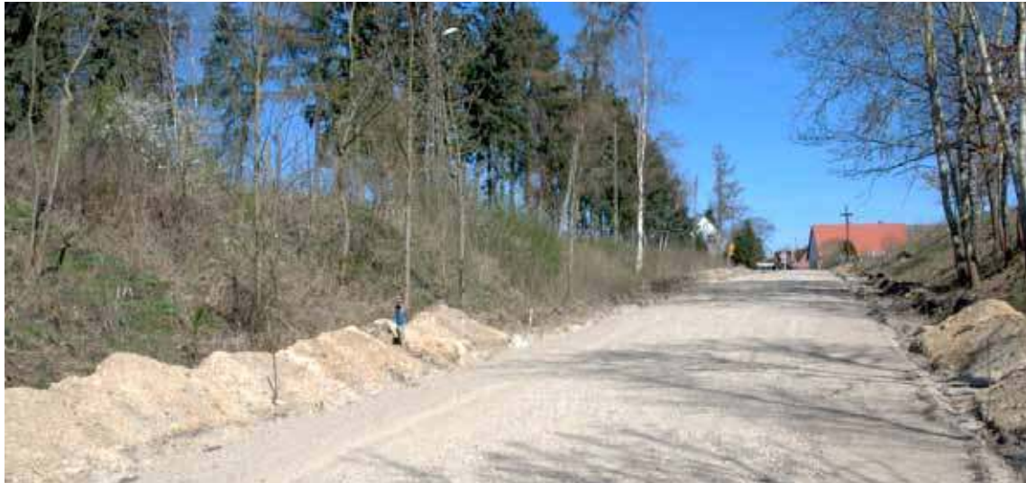
Ekipy remontowe przeprowadzają roboty naprawcze na drogach powiatowych
