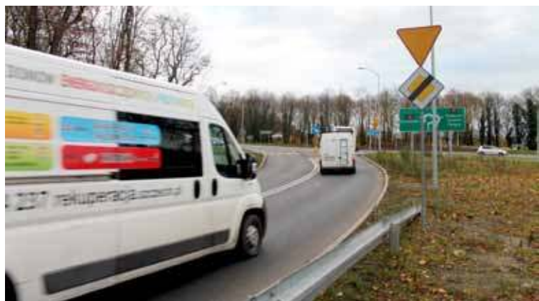
Poprawa bezpieczeństwa na Szosie Maszewskiej zależy od budowy chodnika, wycinki suchych drzew oraz ustawienia znaku w miejscu gdzie zaczynają się posesje, by zapewnić redukcję prędkości aut
