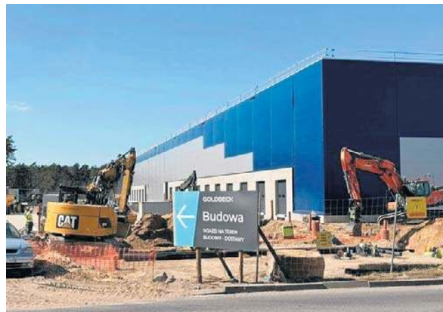
Budowa nowej hali w Bydgoskim Parku Przemysłowo-Technologicznym
