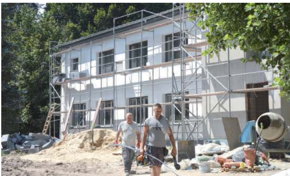
Aktualnie trwają prace związane z dociepleniem elewacji oraz wymianą instalacji. Kładzione są tynki i posadzki, a także wykonywane ścianki działowe wewnątrz
