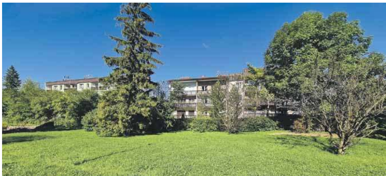
Miejska działka w centrum Zakopanego przechodzi w prywatne deweloperskie ręce.
