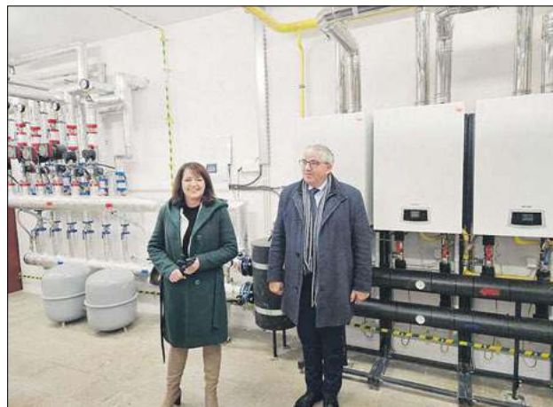
W sarnackiej podstawówce zmodernizowana została instalacja centralnego ogrzewania i zamontowany kocioł gazowy kondensacyjny
