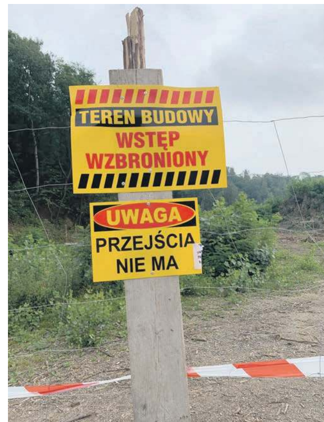
Znaki odgradzające teren budowy przy strefie już stoją
