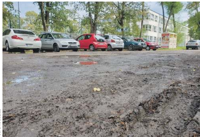
Na razie plac przy ul. Szkolnej przypomina grzęzawisko
