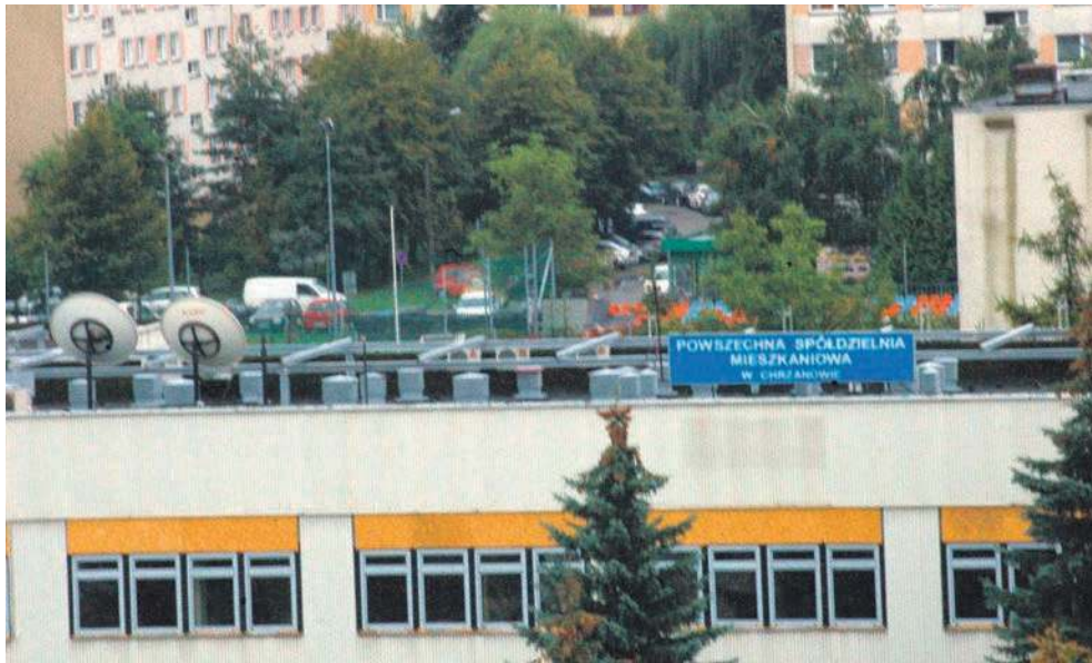
Trwa montaż paneli fotowoltaicznych na biurowcu PSM w Chrzanowie
