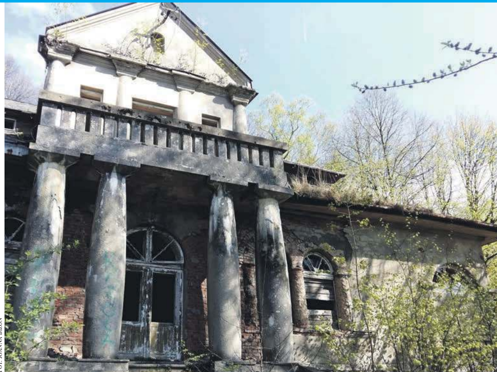
Fasada dawnego szpitalika zakaźnego w Myślachowicach
