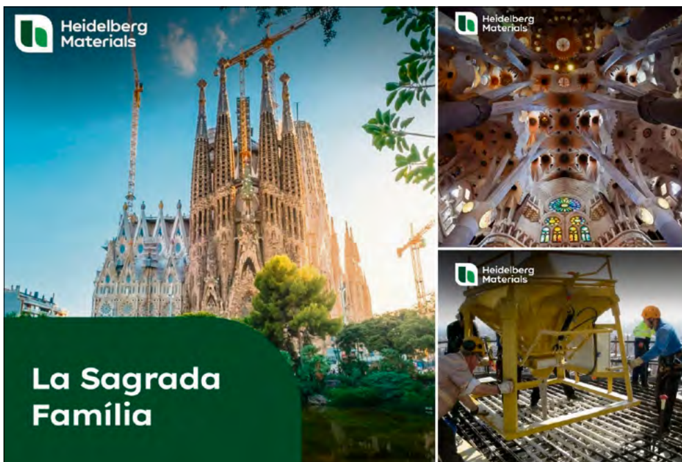
Na potrzeby budowy Heidelberg Materials dostarczył kluczowy materiał – biały beton.
