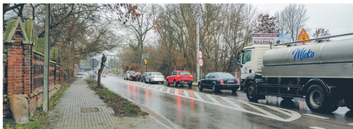
Z powodu remontu kierowcy muszą stać w korkach.
