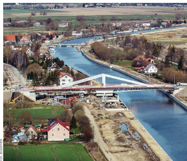
Nowy most obrotowy w Nowakowie liczy ponad 100 metrów, ma usprawnić żeglugę i poprawić komunikację kołową
