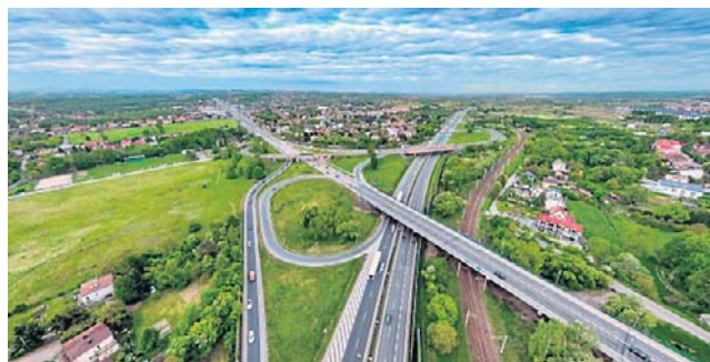
W ramach rozbudowy autostrady A4 powstaną drogi lokalne
