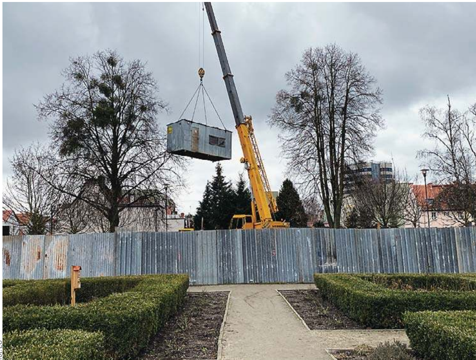
W tym tygodniu rozpoczęto prace budowlane w ogrodzie Różanym
