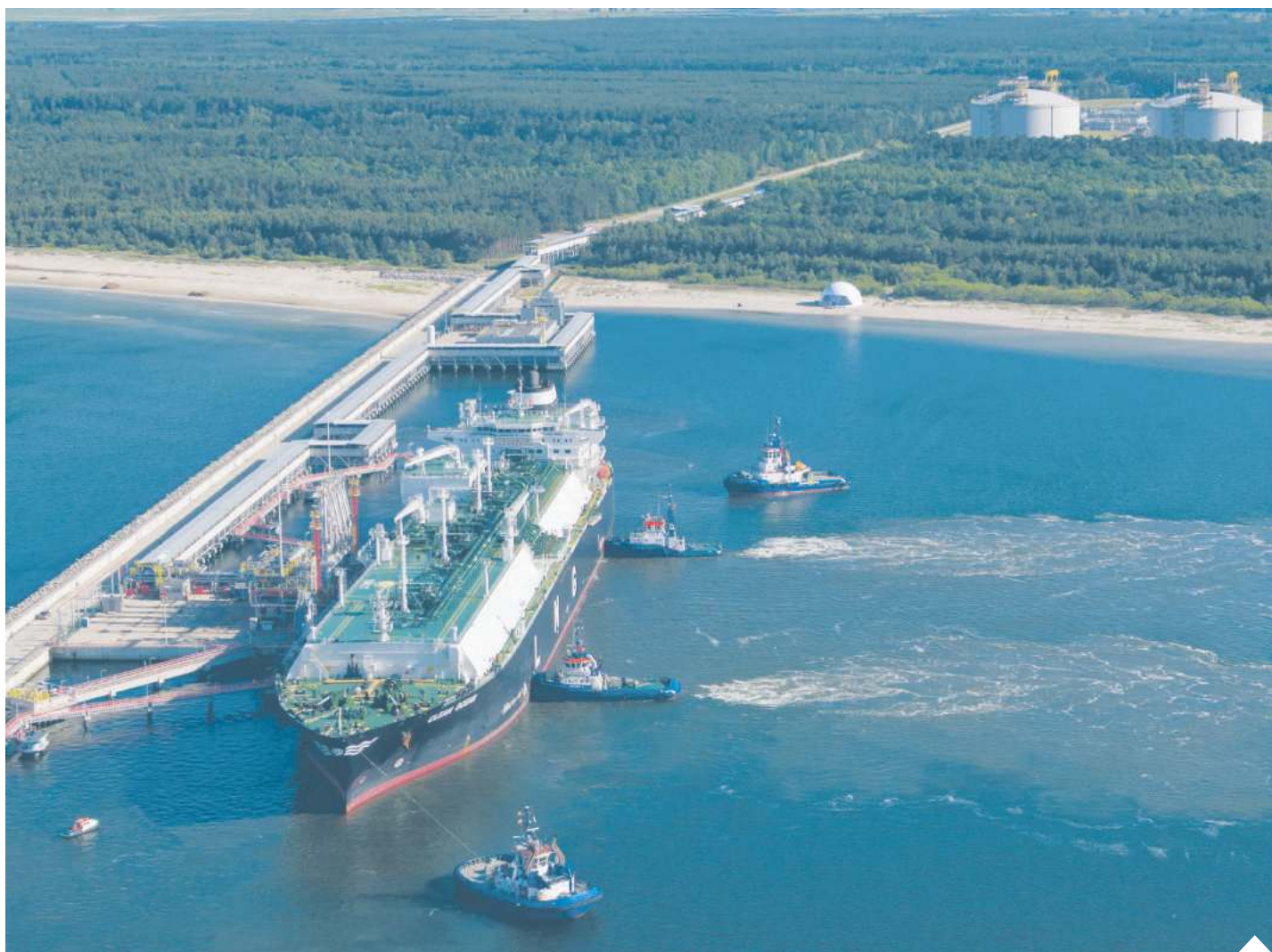
PGNiG od 2016 roku sprowadza skroplony gaz ziemny do Polski poprzez Terminal LNG im. Prezydenta Lecha Kaczyńskiego w Świnoujściu. Ostatnio spółka zarezerwowała dodatkową moc terminalu, która będzie dostępna po jego rozbudowie | fot. mat. pras.
