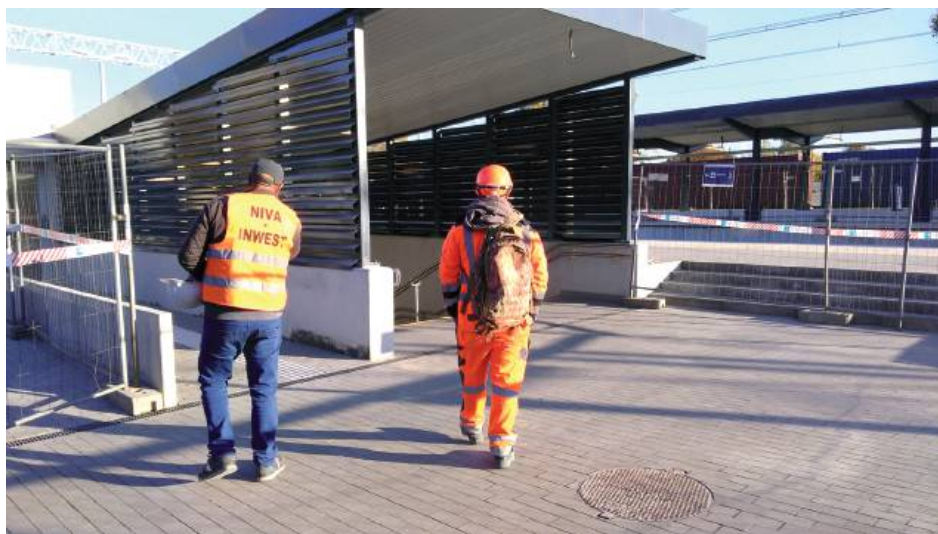
Od czwartku na stacji w Białej Podlaskiej podróżni korzystają z nowego przejścia podziemnego na peron wyspowy
