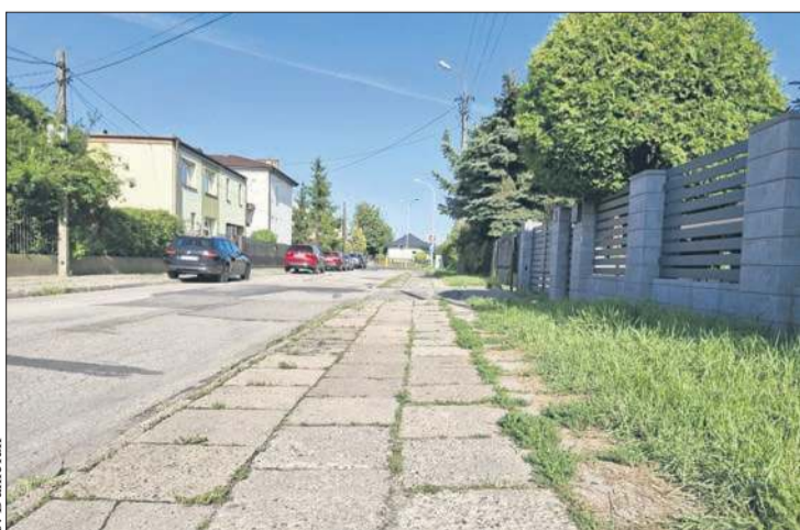
Drugi etap remontu ulicy Lasockiego potrwa do drugiej połowy grudnia tego roku
