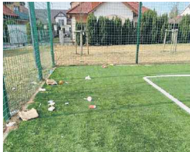
Zniszczone barierki, uszkodzone kosze na śmieci i bałagan.. Tak wygląda dziś boisko na osiedlu Wschód.
