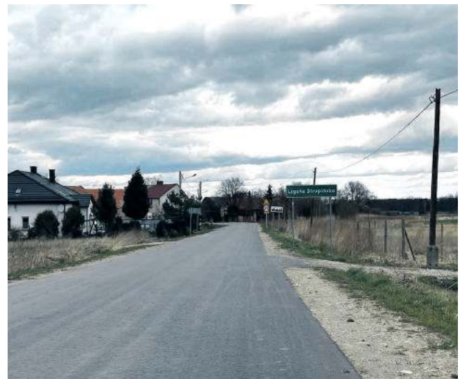
Wyremontowany odcinek drogi wykonany w 2021 roku
