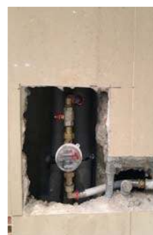
Budowa nowej instalacji w kominie i połączenie z instalacją istniejącą już w mieszkaniu
