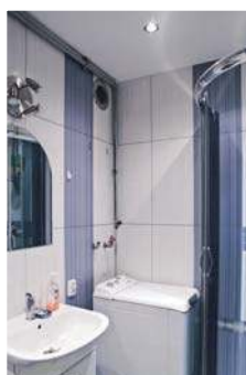
Demontaż piecyka gazowego
