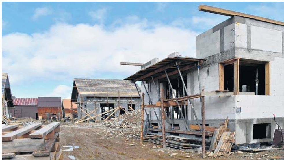
W Nowej Białej trwa odbudowa domów po wielkim pożarze jakie nawiedził wioskę 19 czerwca
