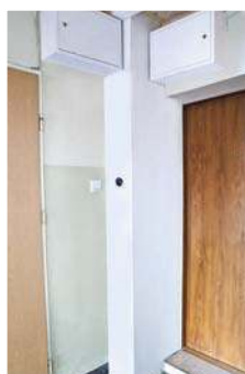
Montaż skrzynki pomiarowej na korytarzu
