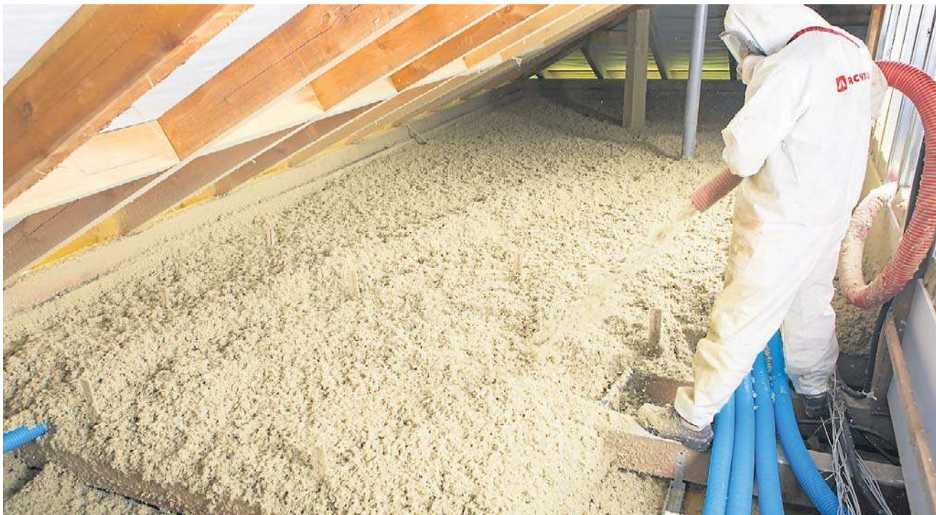
Granulat aplikuje się w technologii nadmuchu. Zaledwie w ciągu 1 dnia możemy zaizolować aż 100 m² poddasza
