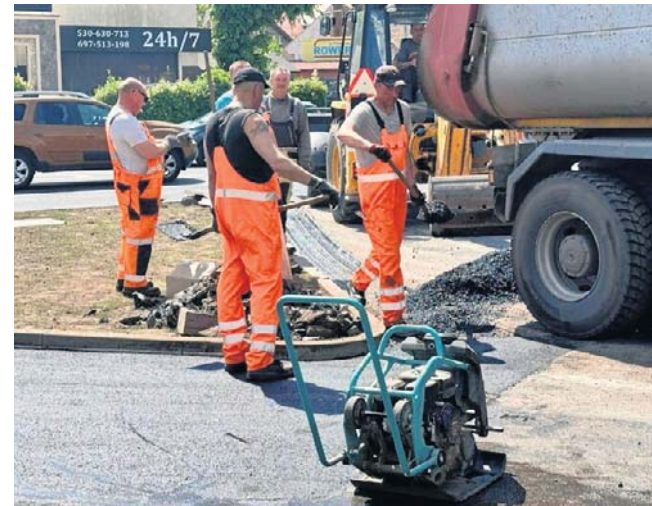
Drogowcy wykonują ostatnie poprawki na nowym skrzyżowaniu ul. Wieniawskiego z al. Podwale w Wałbrzychu.
