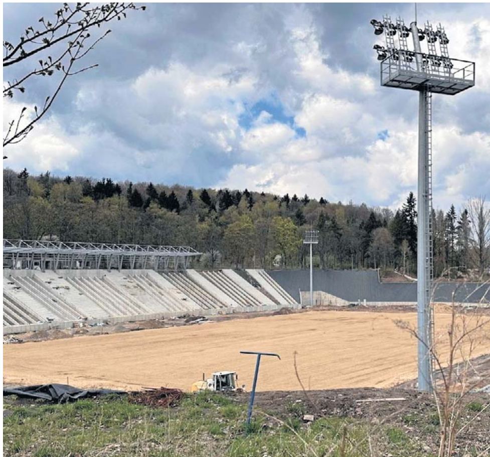
Generalny wykonawca przebudowy stadionu zszedł z budowy, a Tauron wyłączył prąd.
