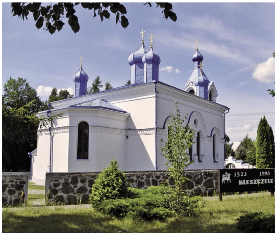
Kleszczelowska cerkiew z dachem prowizorycznie odbudowanym po wojennych zniszczeniach.
