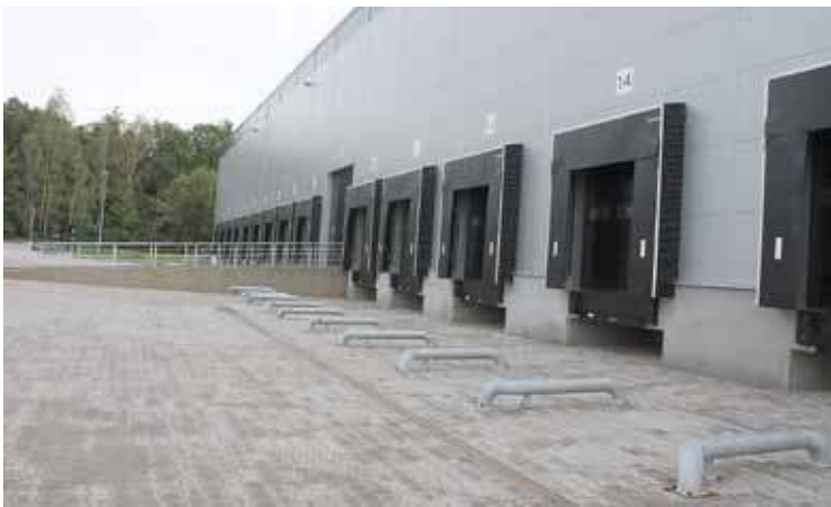
Bramy, z których odbierane będą towary do dalszej, lądowej drogi, aby w końcu trafiły do klienta
