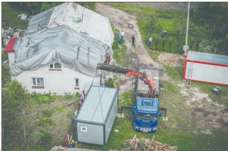
Zniszczenia po przejściu nawałnicy w miejscowości Mokrzek
