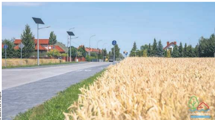
W ramach inwestycji wykonano ponad 1,5-kilometrowy odcinek ulicy Zagłoby
