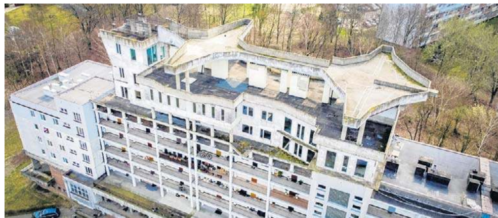
Część nadbudowy została już rozebrana
