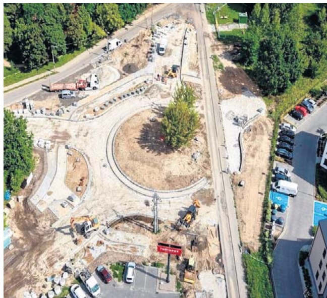
Pod budowę ronda u zbiegu ulic Okólnej i Strzałowej wyciętych zostało około 30 drzew
