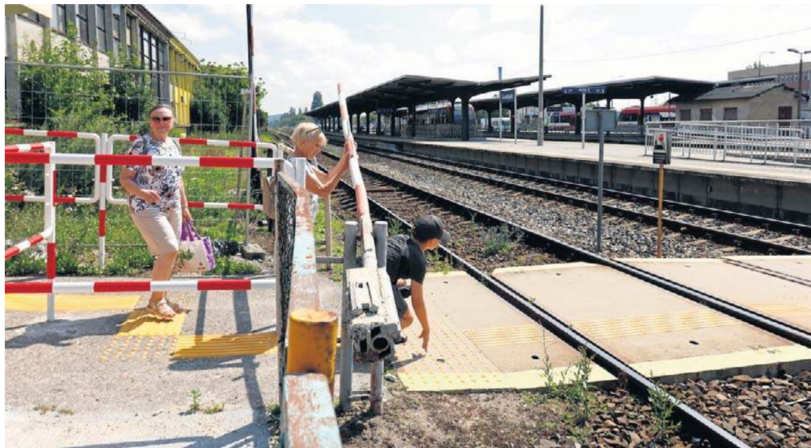
Ponieważ tunel pod dworcem jest zamknięty, na pierwszy peron można dojść tylko przejściem po torach
