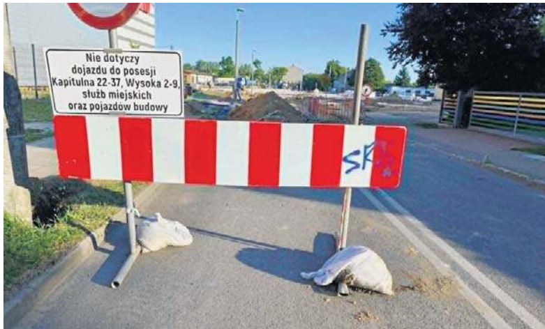
Trwa budowa ronda. Podpisano umowę o dofinansowanie
