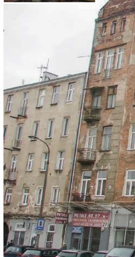
Kamienica przy ul. Wileńskiej 27 i balustrada balkonu
