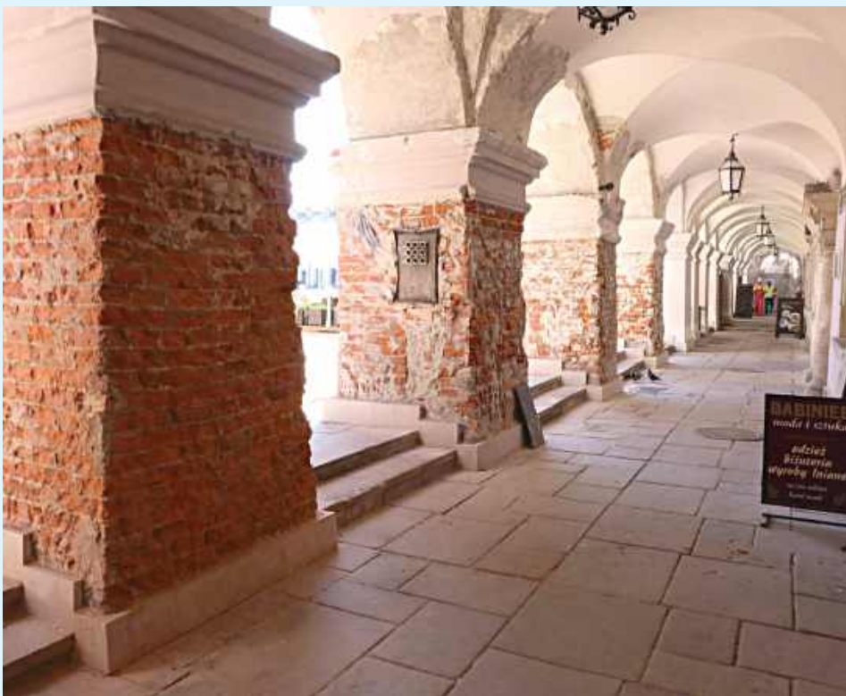
W Zamościu trwa drugi, kluczowy etap remontu zabytkowych podcieni przy ulicy Staszica
