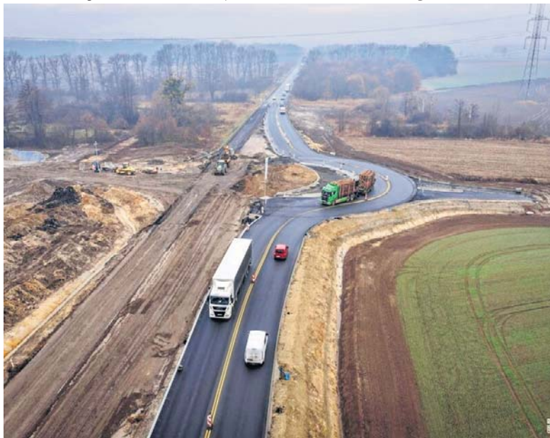
Planowany odcinek „krajówki” połączy się z trasą budowaną obecnie przez miasto, tworząc płynne połączenie z autostradą A4.
