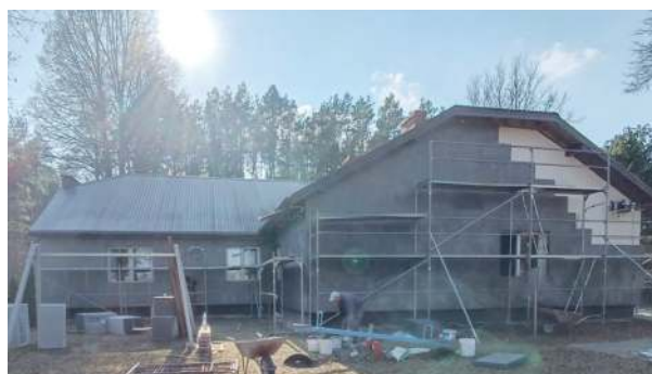
Budynek świetlicy w miejscowości Pościsz
