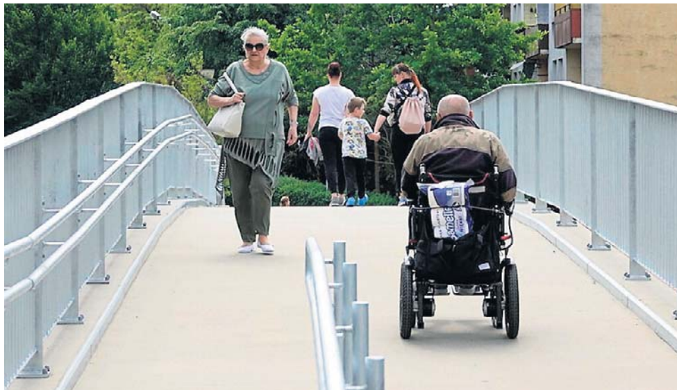
Nowa kładka nad ulicą Sandomierską na Ustroniu w Radomiu jest już gotowa. Mogą z niej korzystać także osoby z niepełnosprawnościami.
