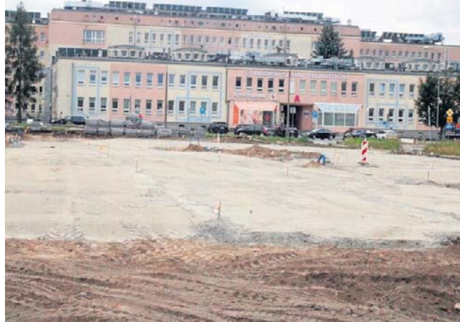
Na fragmencie przyszłego parkingu trwają już przygotowania do układania nawierzchni z kostki.
