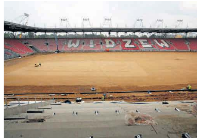
Stadion Widzewa bez murawy - tak przebiegała budowa
