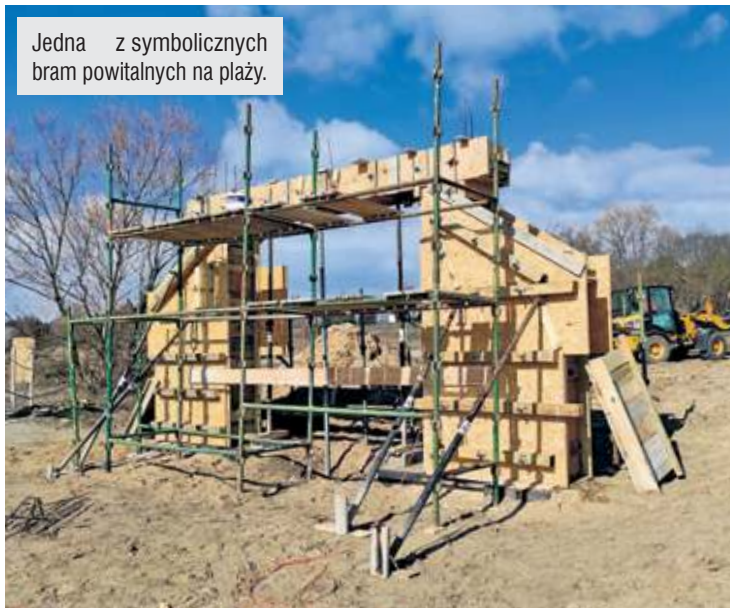
Budynek WOPR-ówki jest już w stanie surowym.
