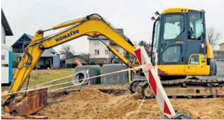
Prace na osiedlu Słonecznym w Brusach realizowane będą do 2023 roku.
