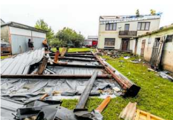
• Skutki przejścia trąby powietrznej w gminie Jedlińsk
