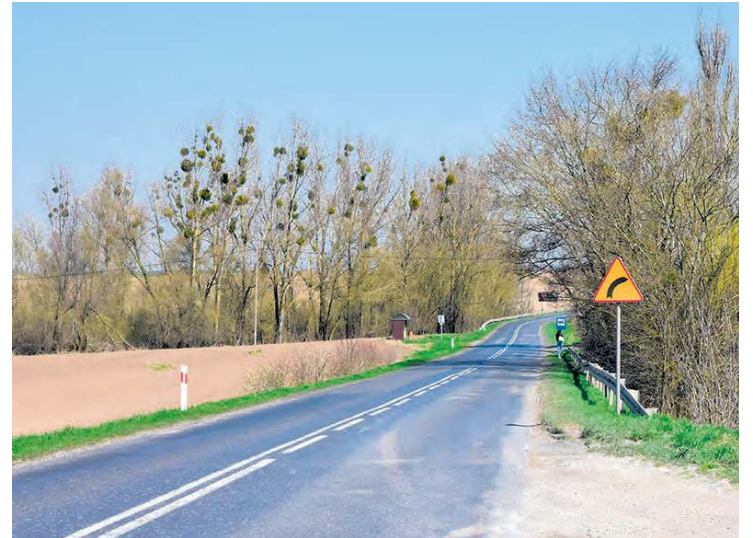
Remont drogi wojewódzkiej 237 wiąże się z wylaniem nowego dywanika asfaltowego.
