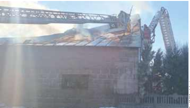
Prawdopodobną przyczyną pożaru było zwarcie instalacji elektrycznej
