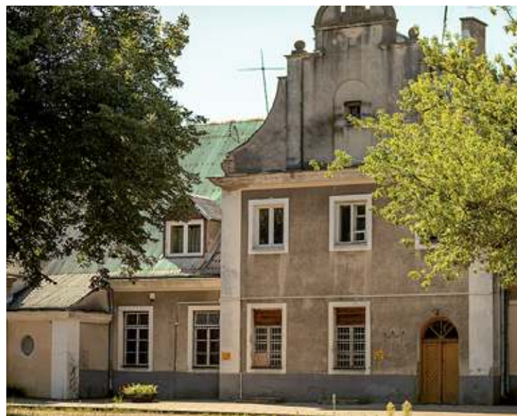
Dworcowy budynek ma być przeznaczony na potrzeby instytucji kultury
