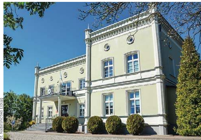
Zabytkowy pałac Abegga przeszedł gruntowny remont
