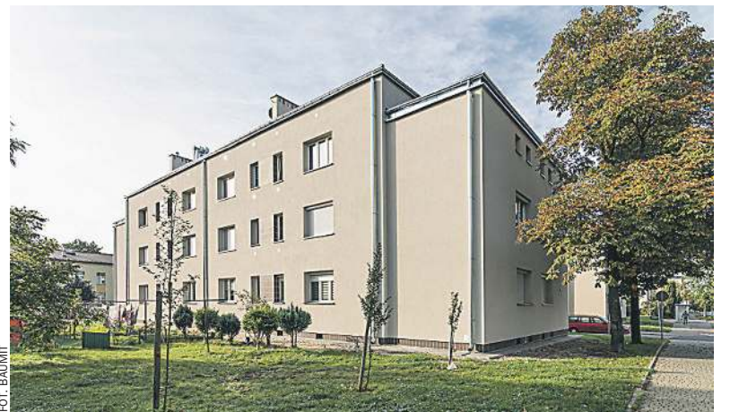
Nasz kandydat do Europejskiej Fasady Roku, blok przy ul. Popiełuszki 29 w Stalowej Woli, w kategorii budynków po termomodernizacji
