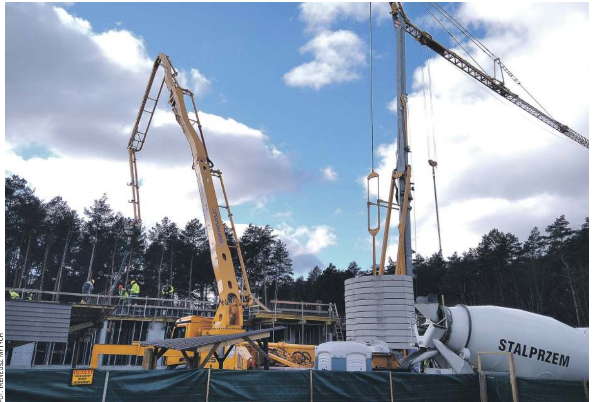
Trwają prace przy budowie trzeciego bloku przy ulicy Orzeszkowej w Stalowej Woli
