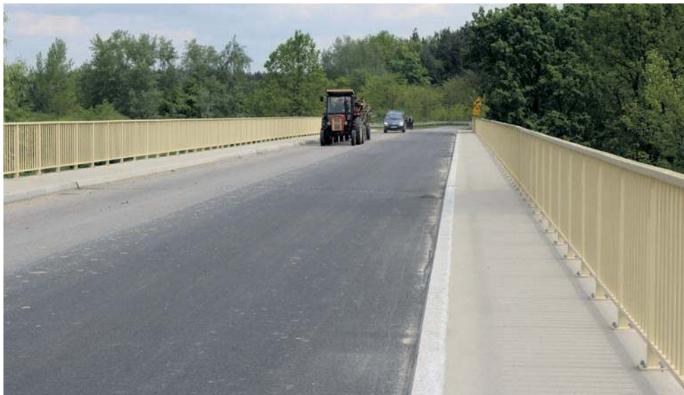
Pierwszy etap modernizacji mostu na Sanie w Radomyślu zakończył się w 2017 roku. W tym roku ma ruszyć drugi etap remontu
