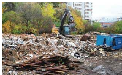
Rozbiórka pustostanu na Zatorzu. Nareszcie! \3
