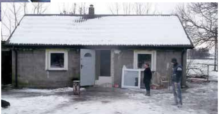
Ten dom po odbudowie
