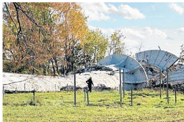
Ładunki wybuchowe podłożone u podnóża obiektu doprowadziły do jego przewrócenia
