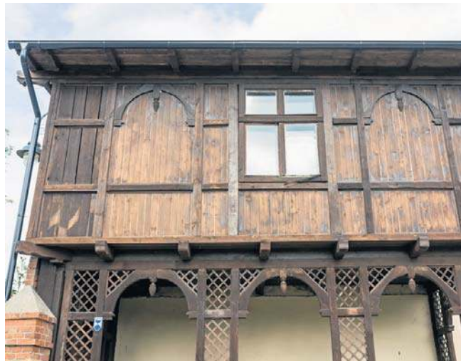
Pierwsze prace przeprowadzono w 2021 roku. Celem było zachowanie oryginalnego drewnianego materiału
