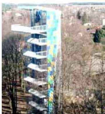
Osoby niepełnosprawne mogą skorzystać ze specjalnej windy zamontowanej na wieży widokowej
