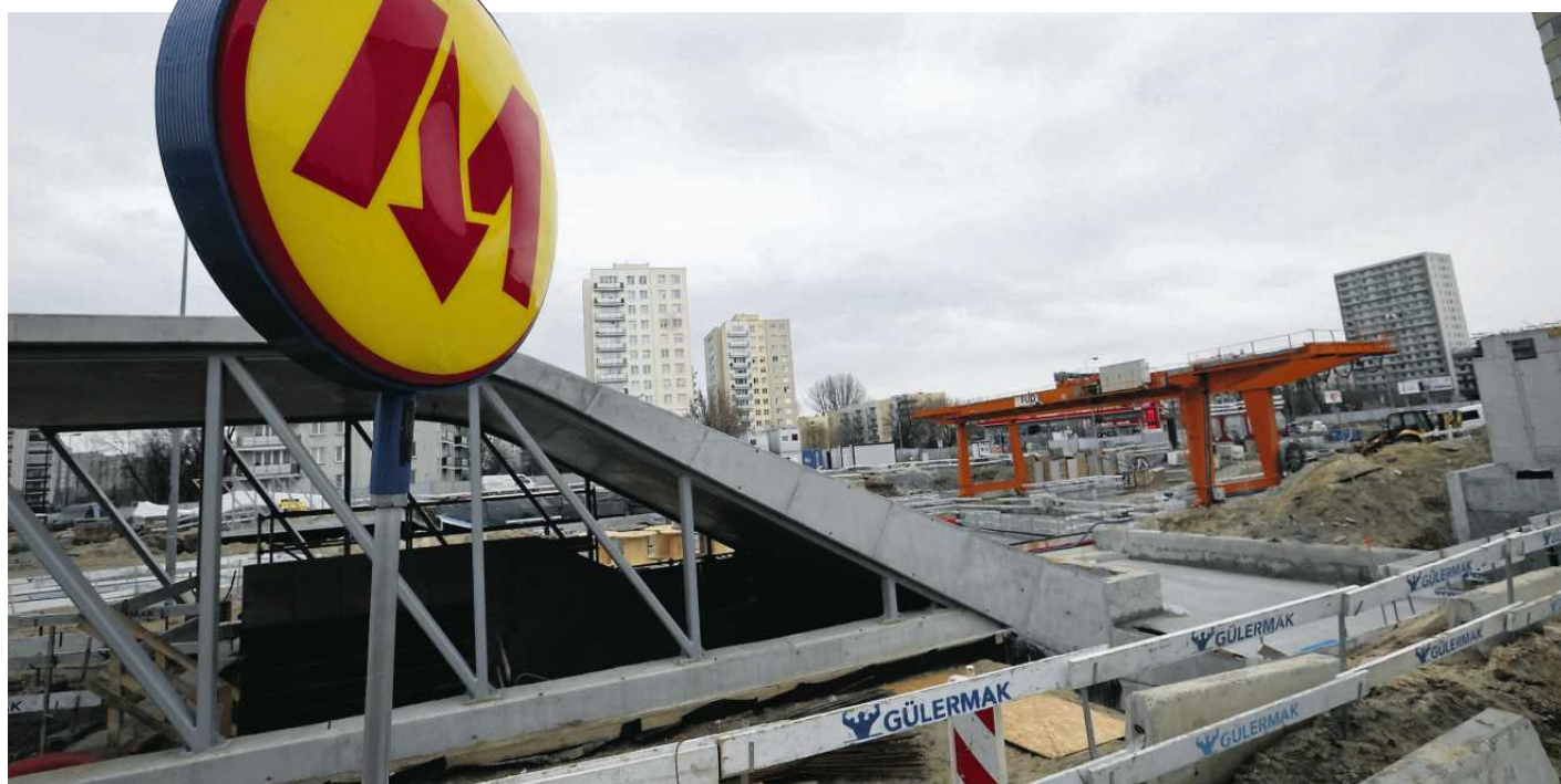
• Budowa stacji Kondratowicza na drugiej linii metra, luty 2021 r.
