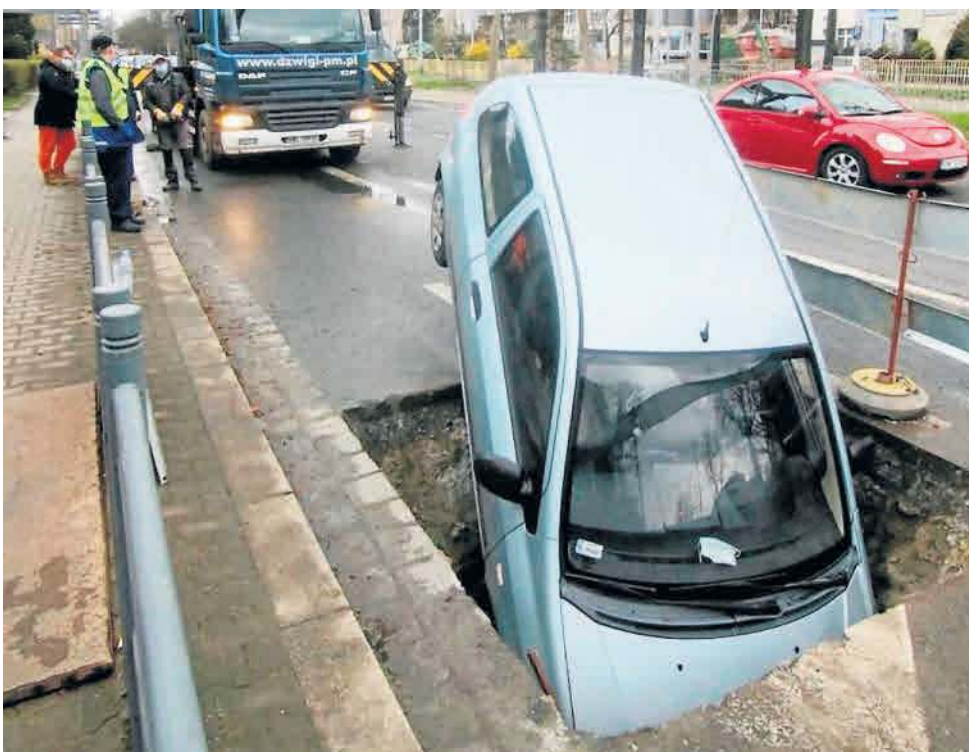
Nietypowe zdarzenie na al. Hallera we Wrocławiu. W czwartek rano kierowca staranował samochodem barierki ogradzające teren robót drogowych i wjechał do wykopu w jezdni
