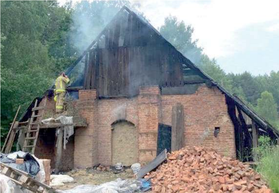
Ze względu na proces wypalania cegły strażacy nie mogli użyć większej ilości wody w natarciu na źródła ognia (fot. OSP Zgórznica)
