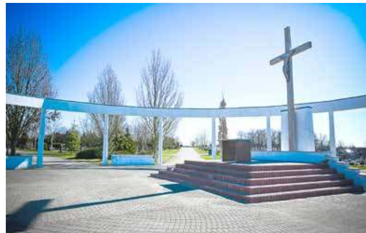
UM zapowiada, że renowacji zostanie poddany także drewniany krzyż przy ołtarzu. Fot. S. Ler
