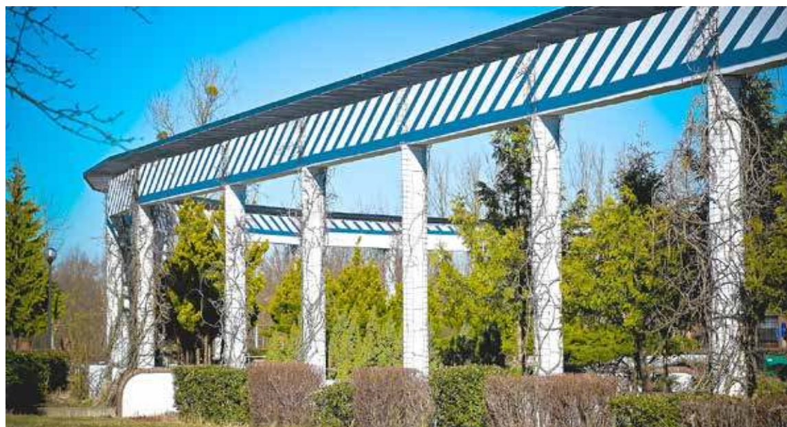
W ramach tego etapu wiosennej inwestycji arkady są czyszczone i odmalowywane, a ubytki uzupełniane
