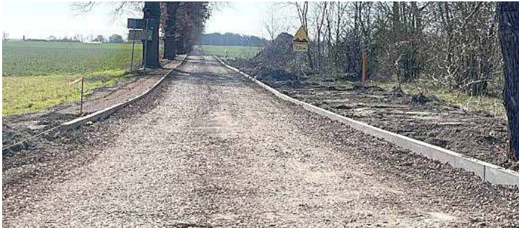
Remontowany jest odcinek o długości 2186 mb.
