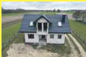
Dom w stanie surowym otwartym, Wólka Siemieńska, 885 851 160
